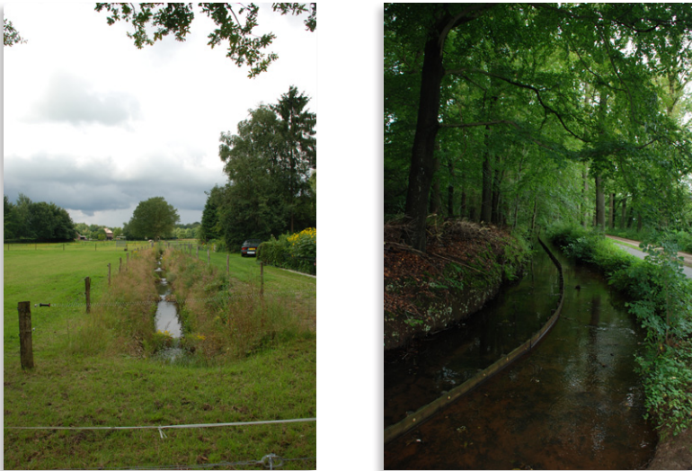
Figuur 7.5: Vistrap (links), Nieuwe Beek en Rode Beek na oplevering eerste traject weer gescheiden door schot (rechts)
